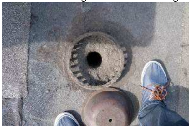
Sadevee toru on liiga väikese läbimõõduga
