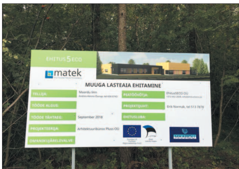
Uus lasteaed Muugal muutub reaalsuseks. Tulevasel ehitusplatsil algasid ettevalmistustööd ja võsaraie. Hoiame põialt, et tuleb pehme talv ning ehitajad saavad lõpetada ehitustööd tuleva aasta sügiseks.
