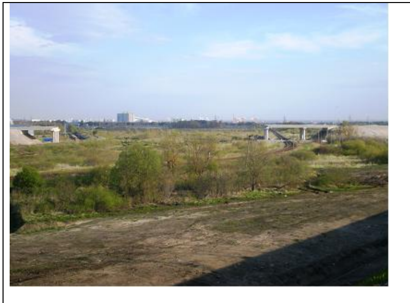
Pilt 2. Põhjapoolse kogujatee raudteeviadukti ehitus on peatatud
