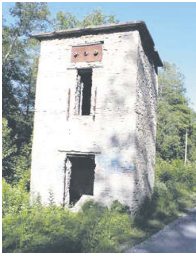
See on kõik, mis on jäänud alles ettevõttest, mis tegeles fosforiidide kaevandamise ja ümbertöötlemisega; tegutses aastatel 1920-1938.
