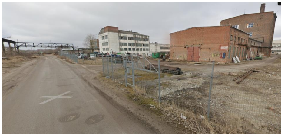
Foto 2. Alus google.com.map, foto 2023 a. Vaade Lao tänavalt olemasolevatele Lao tn 10 kinnistu hoonetele.
